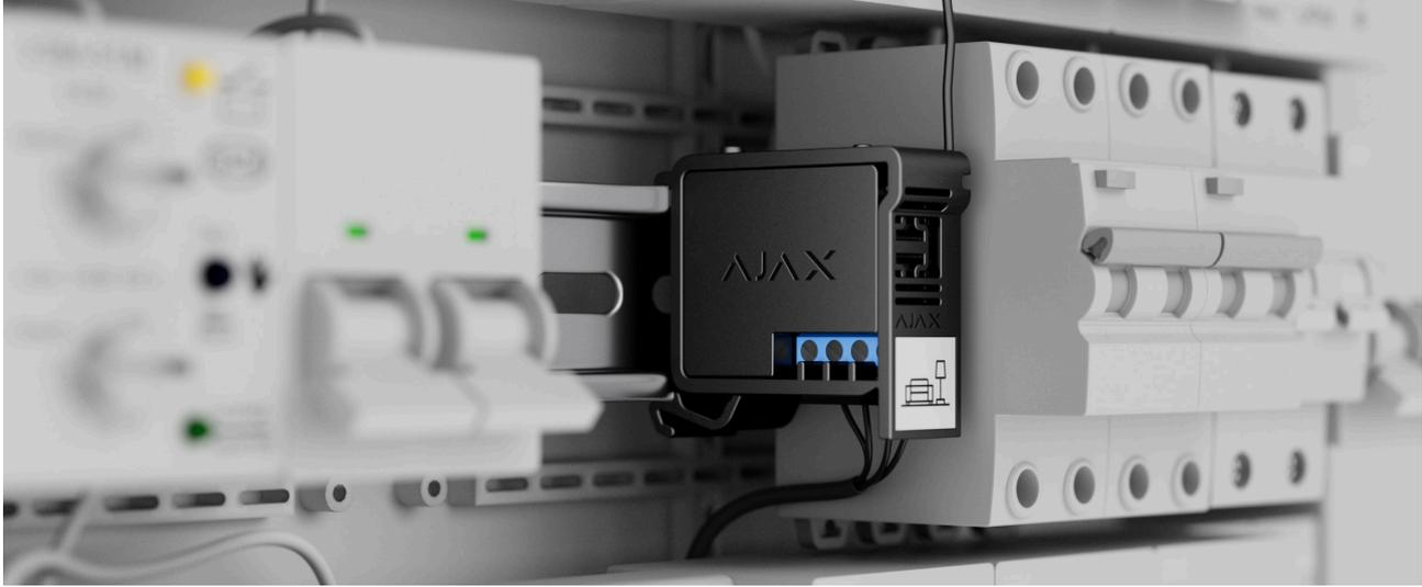
El dispositivo con un tamaño de 39 × 33 × 18 mm se conecta a una brecha del circuito. Las dimensiones del Relay permiten instalarlo en una caja de conexiones profunda, dentro de la carcasa de un aparato eléctrico o en un tablero eléctrico. La antena externa flexible garantizará la estabilidad de la comunicación. Para instalar el Relay en un carril DIN, recomendamos utilizar el [DIN Holder](#).
